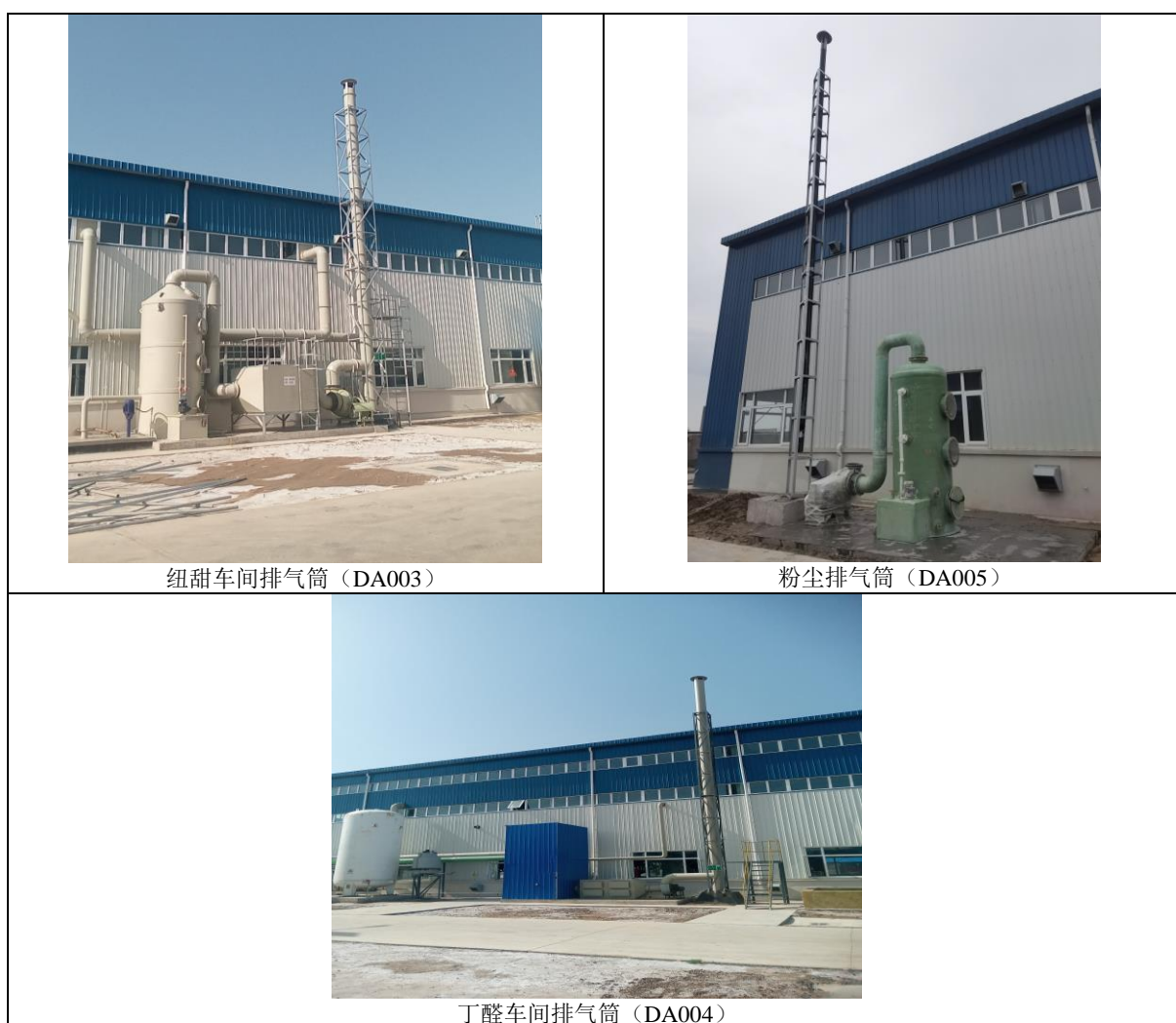
图 4-1 有组织废气处理设施图
